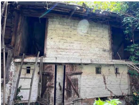
Foto 21: Ehemaliger Stall und Brennholzlager (3)
