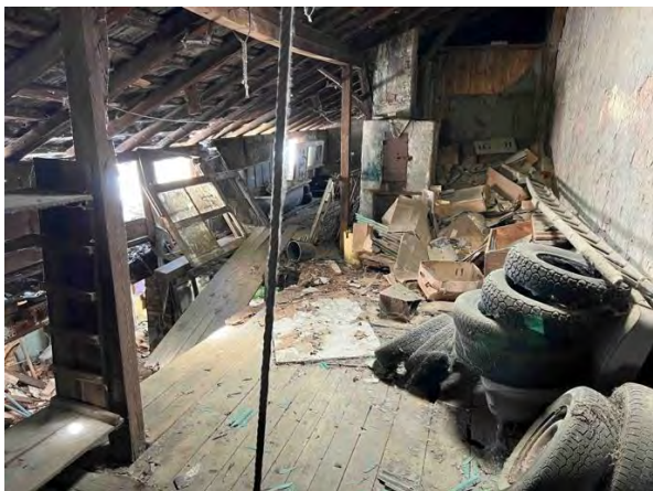
Foto 9: Scheune (4) (oberer nördlicher Bereich)
