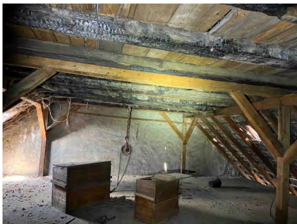
Foto 11: Scheune (4) (oberer Zwischenboden)
