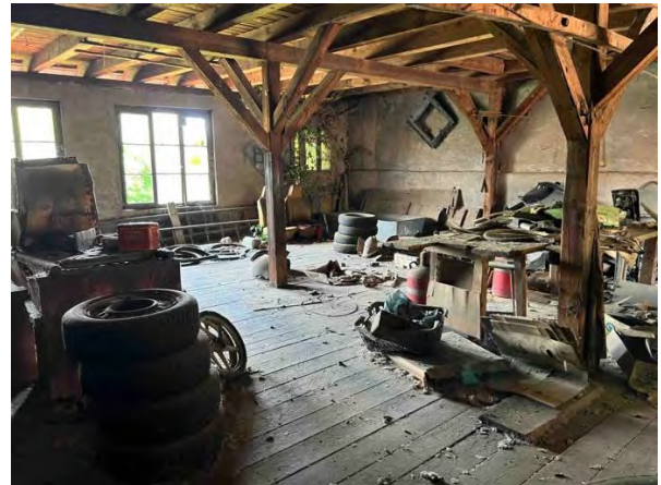
Foto 10: Scheune (4) (Dachboden, südlicher Bereich)
