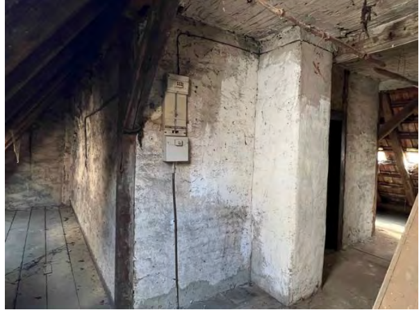
Foto 18: Wohnhaus Nr. 69 (8) (Dachstuhl)
