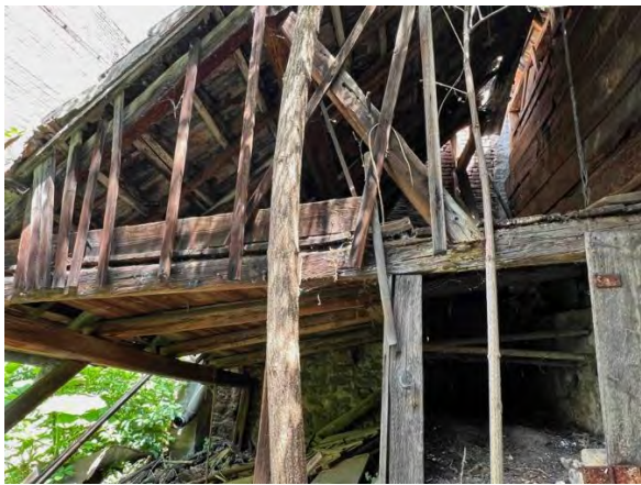
Foto 20: Kleiner Anbau (2) (Holzschuppen)
