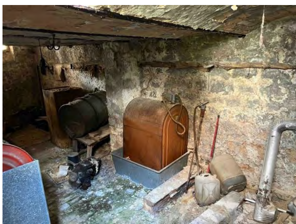
Foto 15: Keller des kleinen Anbaus (6)
