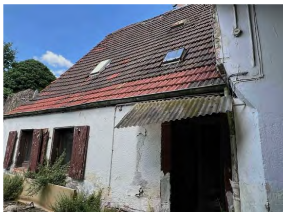
Foto 1: Kleines Wohnhaus hinter Nr. 69 (1)
