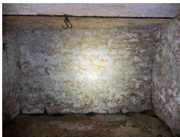
Foto 26: Große Scheune (10) (Kellerraum)
