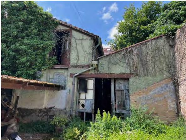
Foto 5: Scheune (4) (Blick aus NE)
