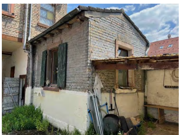
Foto 14: Anbau Wohnhaus Nr. 67 (6)
