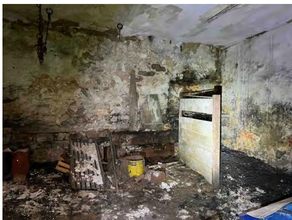
Foto 23: Scheune (9) (ehem. Stall und Kohlelager)
