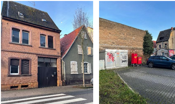
Abb. 2: Bestandssituation - Blick von der Hauptstraße nach Westen auf Haus Nr. 67 und 69, bestehende Parkplätze und Trafostation der Netze BW (Eigene Aufnahmen, Dezember 2025)
