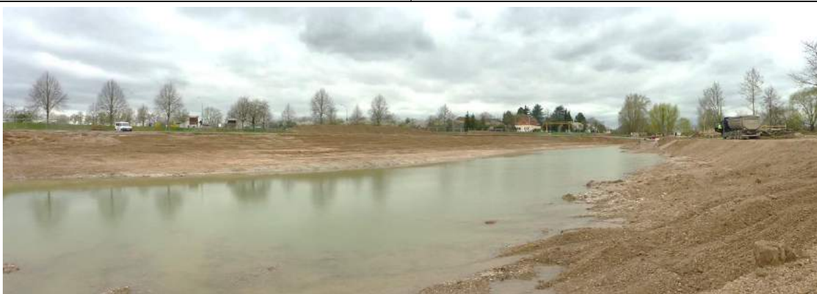
Erdarbeiten: Das Seitengewässer ist in Längsrichtung zu 75 % ausgehoben, zur Abfuhr bereite Kiesmengen lagern am Ostufer.
