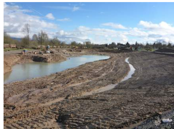
Aushub des Seitengewässers
