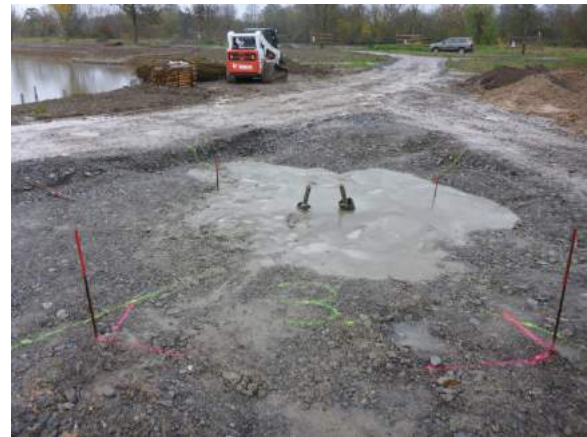
Sonnensegel: Betonage der Zugpfähle
