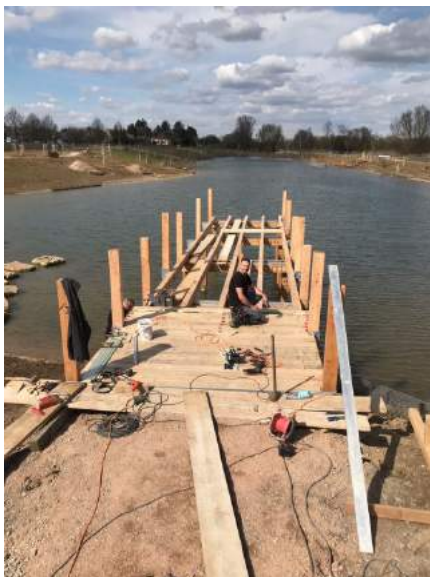
Verlegen der Belagsdecke
