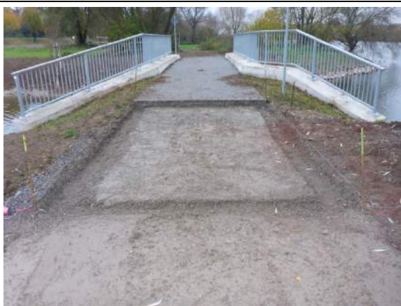
Wegebau Natursteinarbeiten, Auskofferungen für eine Pflasterzeile
