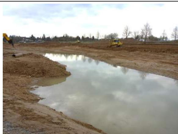
Aushub des Seitengewässers
