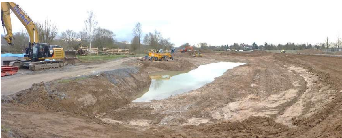
Aushub des Seitengewässers
