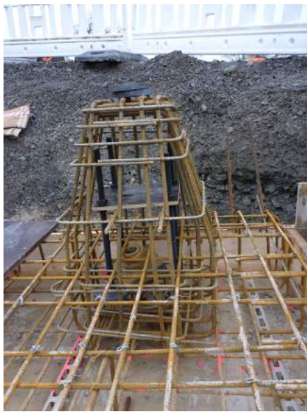
Stahlbewehrung (s.o. und Bild rechts)
