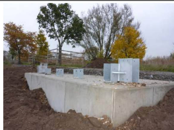
Stege und Plattform: Fertiggestelltes Fundament, Ostufer Als Auflager für Holzbalken und Längsträger
