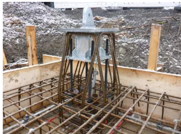
Montiertes Stahleinbauteil mit Augblech
