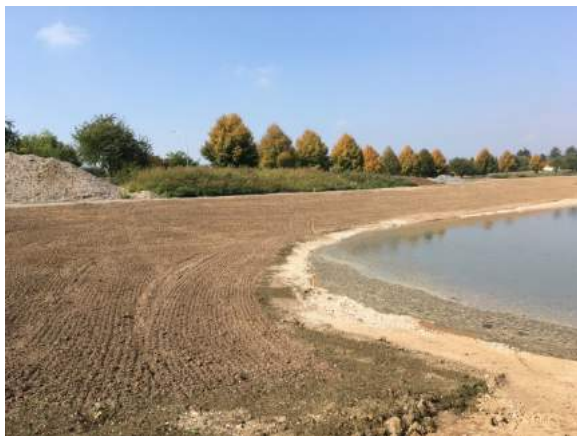
Vegetationstechnik: Bodenlockerung und Ansaat
