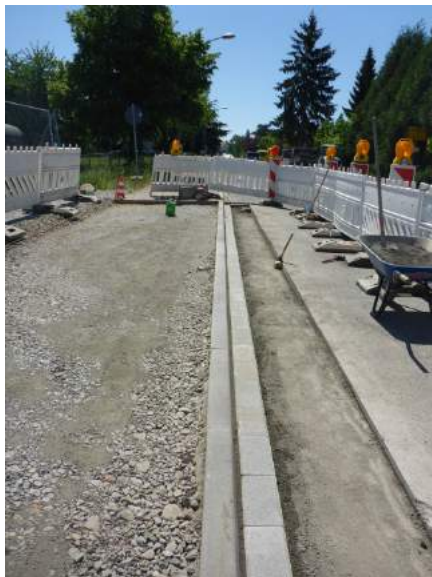
Rückbau Bauzufahrt: Wiederherstellung Hochbordanlage, neue Asphaltierung des Straßen- und Gehwegbelags
