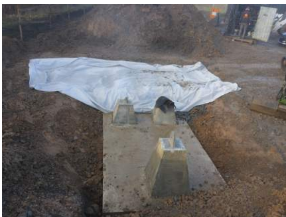
Mit Geotextil ummantelte Sickergrube I
