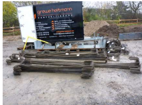
Sonnensegel: Bewehrungstahl für Fundamentplatten (s.o.)
