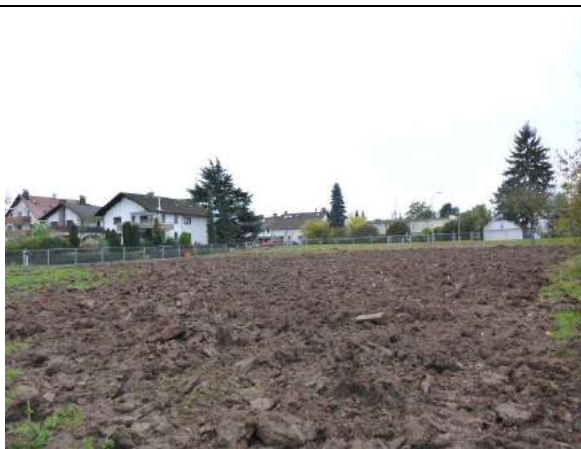
Rekultivierung BE-Fläche: Tiefenlockerung baulich beanspruchter Baueinrichtungsflächen
