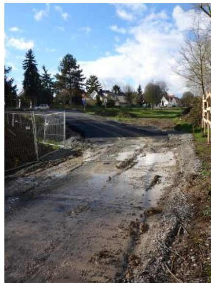
Baustellenausfahrt: Rampe in Asphaltbauweise
