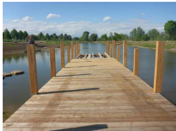
Verlegen der Belagsdecke
