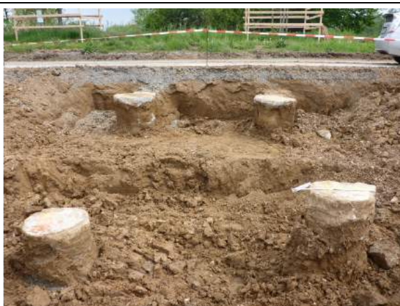
Tiefgründungen der Stege: Betonierte Bohrpfähle, freigelegt
