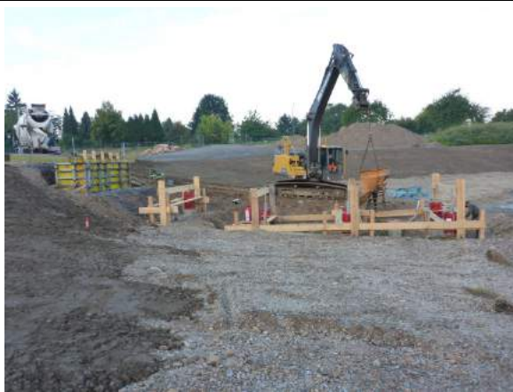
Stege und Plattform: Betonage
