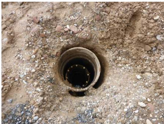
Tiefgründungen für Stege: Herstellung der Schneckenborhpfähle für die Pfahlfundamente
