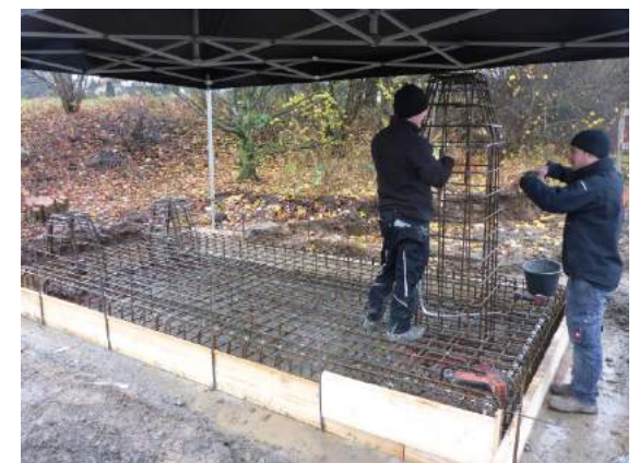
Einbau der Stahlbewehrung (Bild oben) Blitzschutz (Bild links)
