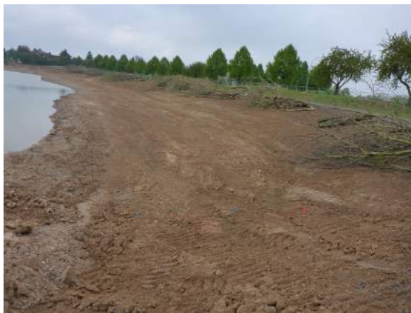
Totholzstrukturen: Lagerung der Raubäume am Westufer zum Einbau
