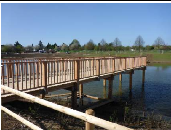
Montage der Brüstung
