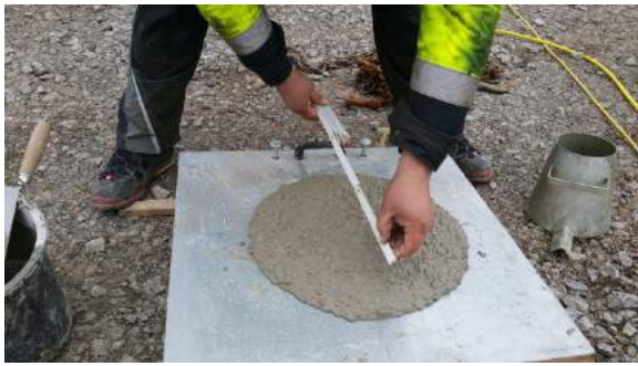
Südliches Brückenwiderlager: Qualitätskontrolle Beton, Ausbreitversuch
