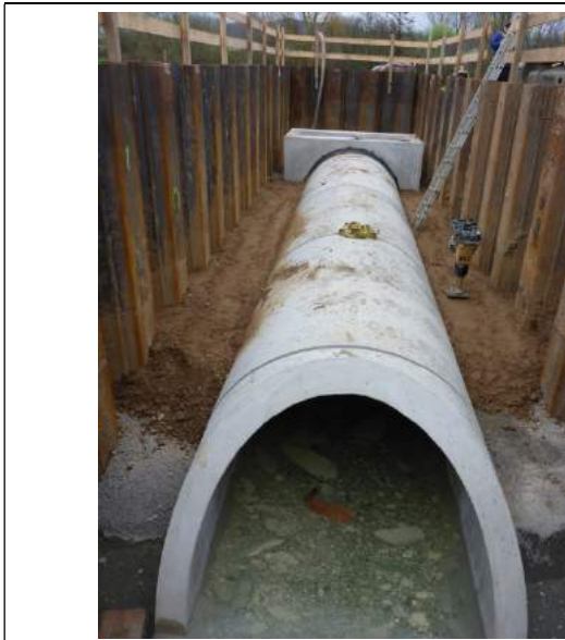
Rohrdurchlass: Nach der Montage, Verfüllung der Baugrube
