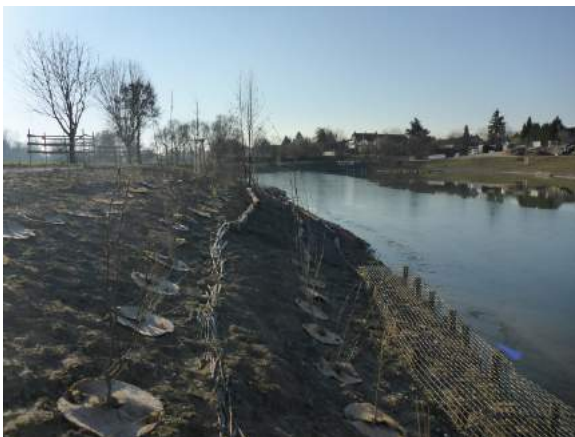
Vegetationstechnik: Strauchpflanzung am Ostufer mit Mulchscheiben für Schattengare
