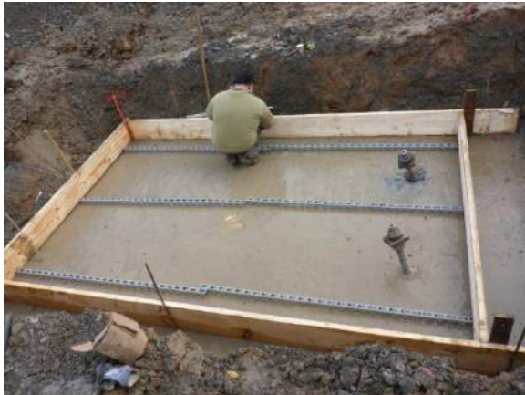
Einbau seittl. Wandschalung u. Abstandhalter
