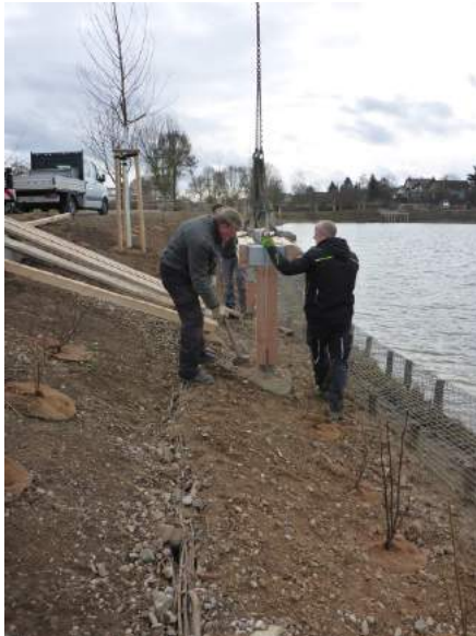
Einbau der Trägersysteme
