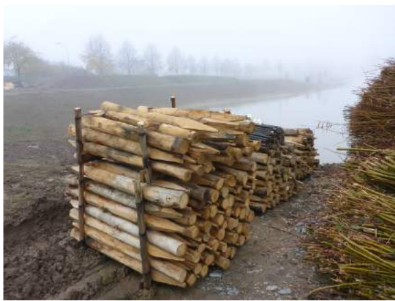
Materiallieferung: Holzpfähle zur Befestigung der Drahtgitterkörbe
