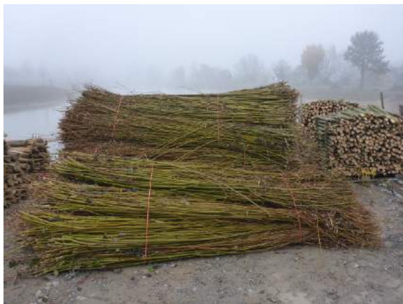
Materiallieferung: Weidenäste für Spreitlage
