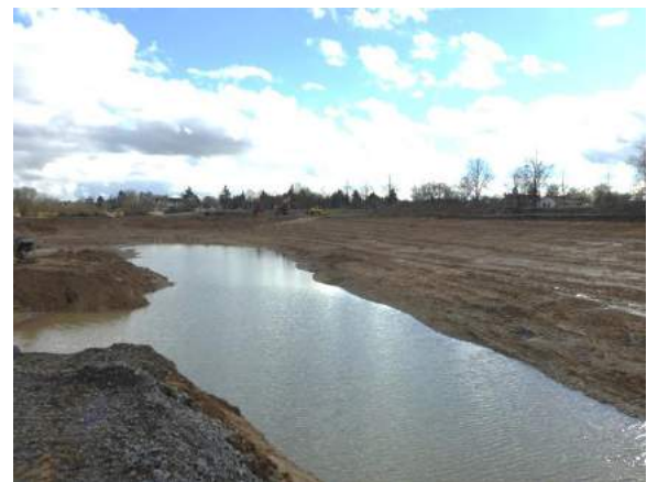
Aushub des Seitengewässers
