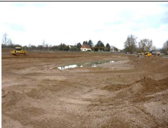
Aushub des Seitengewässers (Kiesabtrag)
