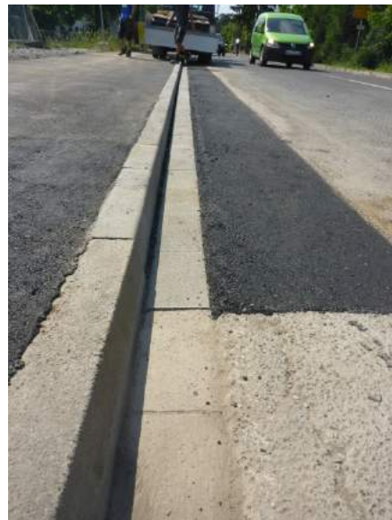
Rückbau Bauzufahrt: Wiederherstellung Hochbordanlage, neue Asphaltierung des Straßen- und Gehwegbelags
