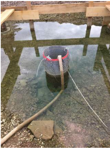
Wasserhaltungsmaßnahmen: Pumpe mit Saugleitung im Arbeitsbereich des Stegs am Südufer
