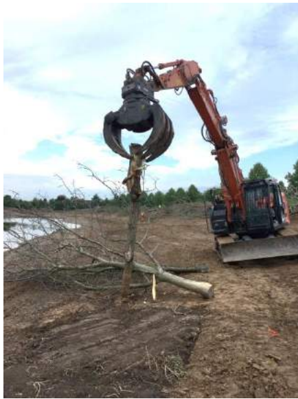
Totholzstrukturen: Die Pflöcke werden in den Boden gerammt
