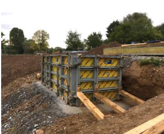
Stege: Fundamentalschalung für Flachgründung des Stegs am Südufer
