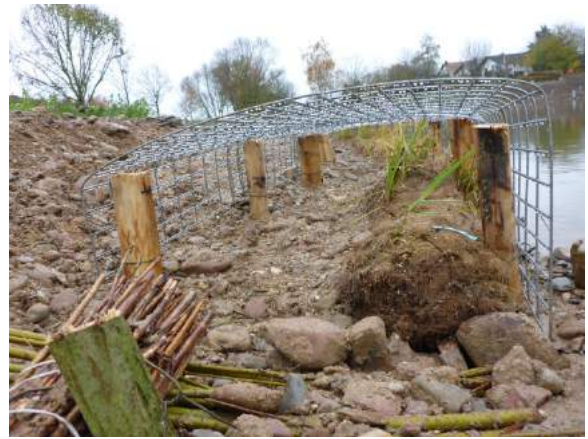
Röhrichtwalze mit Verbiss-Schutz
