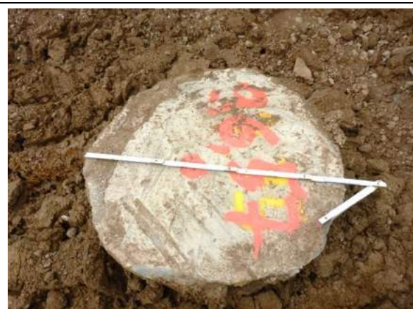
Tiefgründungen der Stege: Kontrollmessungen am Bohrpfahl
