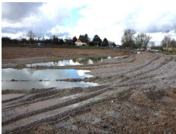
Aushub des Seitengewässers
