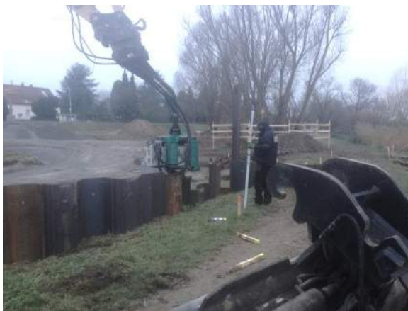
Spundwandarbeiten, Brücke: Für das Brückenbauwerk werden Spundwände mit einer Ramme in den Boden eingetrieben.
