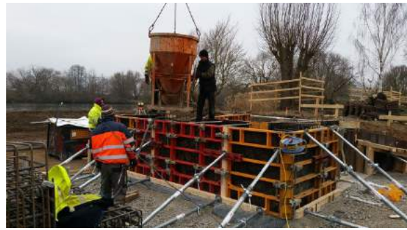
Südliches Brückenwiderlager: Betontage
