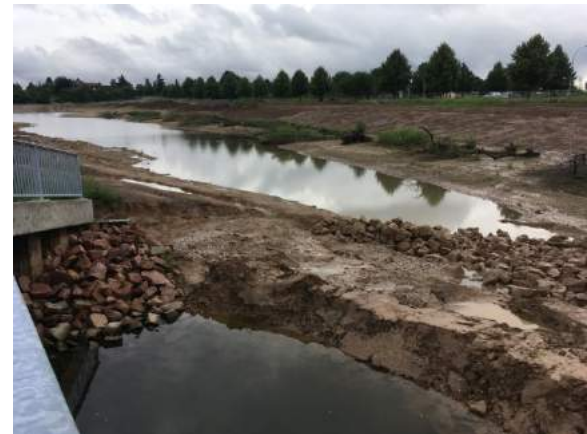
Wasserhaltungsmaßnahmen: Wasserrückhaltedamm hie im Vordergrund des Bilds zu sehen, Absenken des Wasserstands durch Wasserhaltungsmaßnahme
