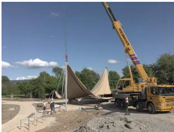
Sonnensegel: Aufrichtung des Gewebes
