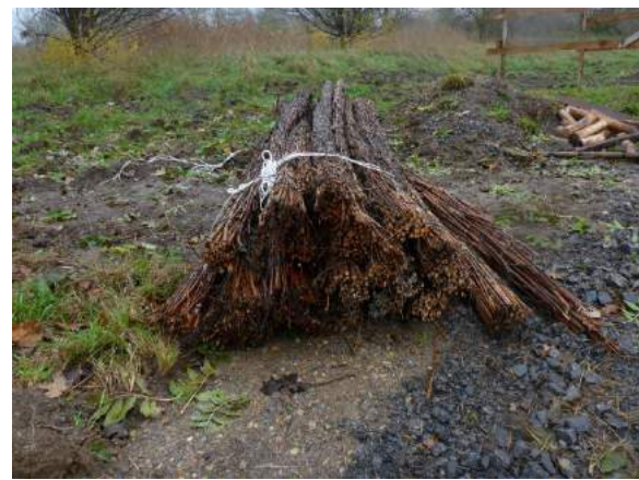
Materiallieferung: Reisig für Totholzfaschinen
