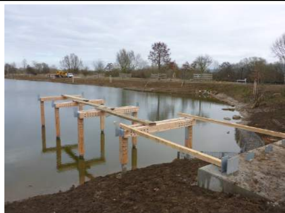
Einbau des Tragwerks (U-Ständer)
