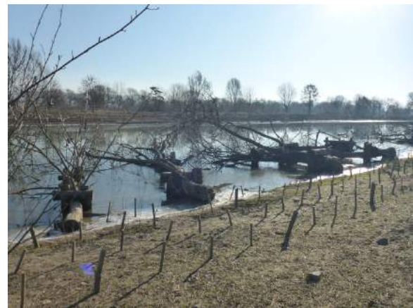
Vegetationstechnik: Weidensetzstangen am Westufer, mit Raubbäumen im Hintergrund
