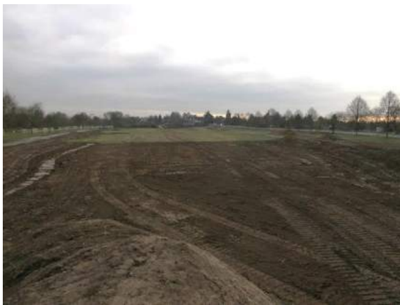
Oberbodenabtrag: Oberbodenabtrag im Bereich des künftigen Seitengewässers
