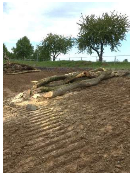
Totholzstrukturen: Zu Pflöcken verarbeitete Baumstämme
