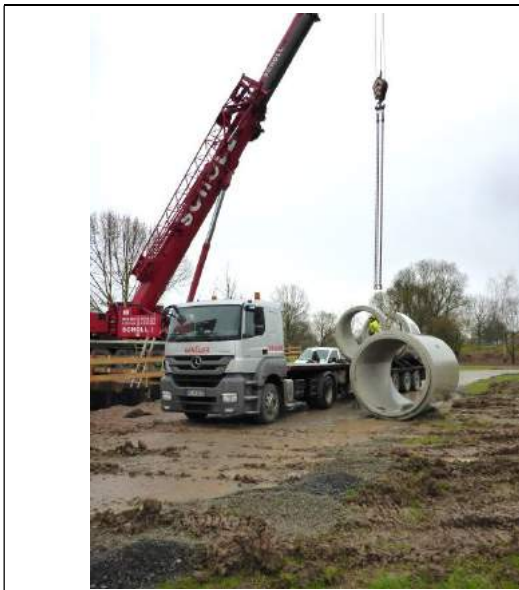
Rohrdurchlass: Anlieferung der Betonfertigteile
