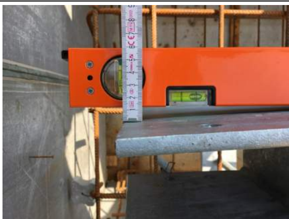
Stege und Plattform: Flachgründung, Balkenschuh: Kontrollmessung
