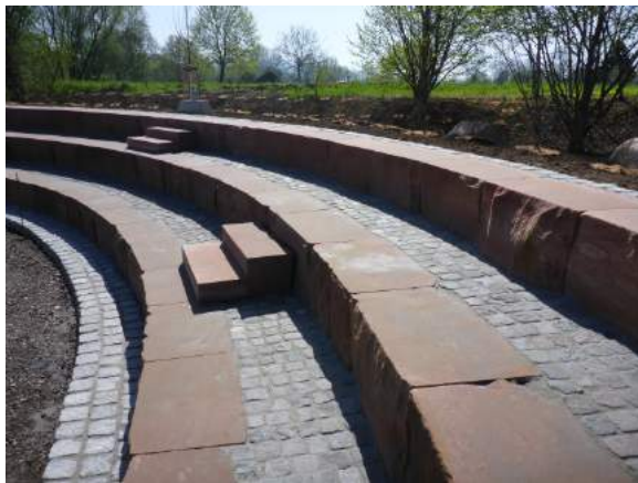
Zwischenpodeste, ausgepflastert mit Naturstein, gemischtes Pflaster, bauseitig gestellt
