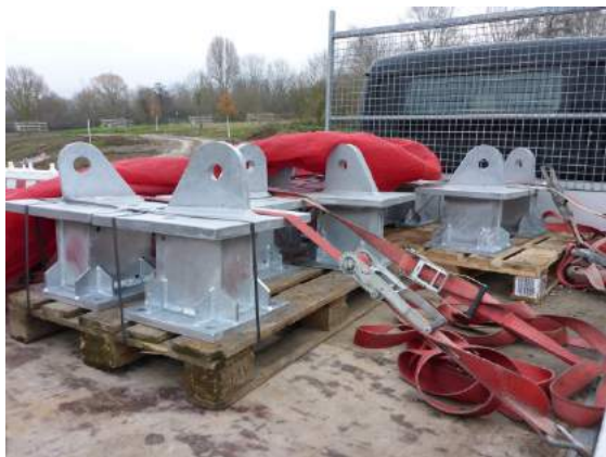
Gelieferte Stahleinbauteile mit Augblech
