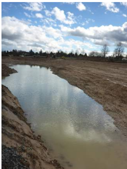
Aushub des Seitengewässers
