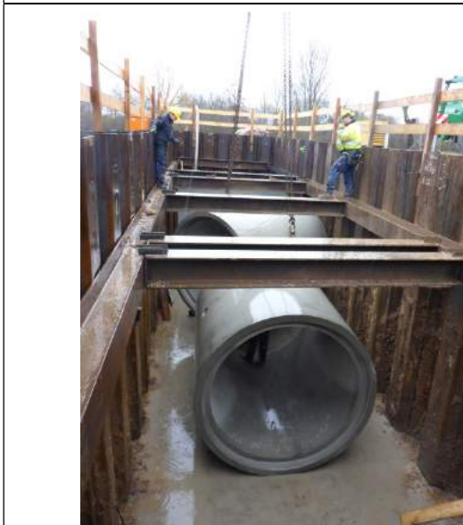
Rohrdurchlass: Montage der Betonteilfertigteile
