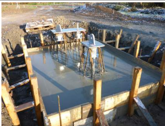
Fundamentplatte f. Sonnensegel nach Betonage
