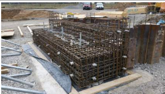
Nördliches Brückenwiderlager: Stahlbetonarbeiten: Einbau der Bewehrung aus Rundstahl
