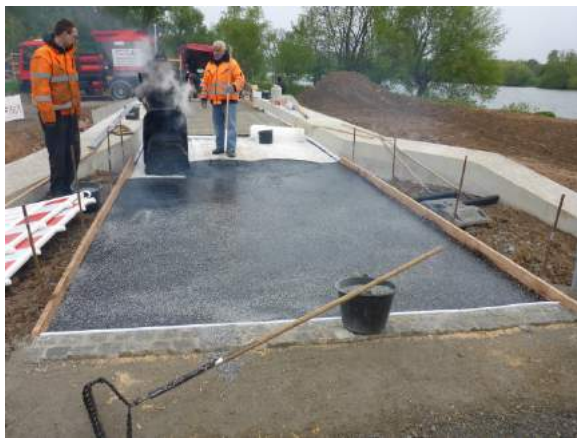
Brücke: Wegebau, Asphaltarbeiten, hier: Einbau von Gussasphalt, Bild rechts: Abstreuen mit Nautursteinsplitt
