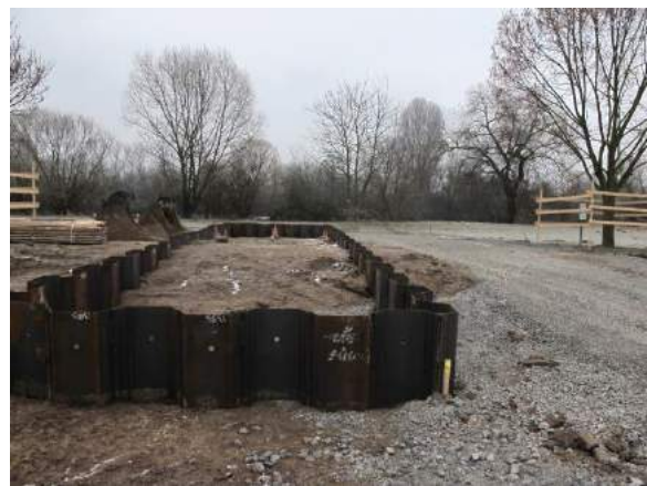
Spundwandarbeiten, Rohrdurchlass: Herstellung einer Spundwand zur Sicherung der Baugrube
