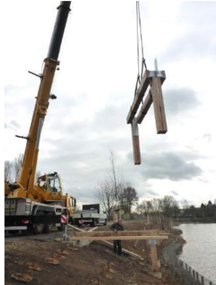
Einbau der Trägersysteme
