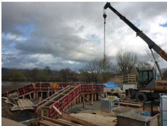
Brücke: Vor und nach der Betonage der Kopfbalken
