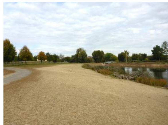
Vegetationstechnik: Abdeckung der Ansaatflächen mit Strohmulch
