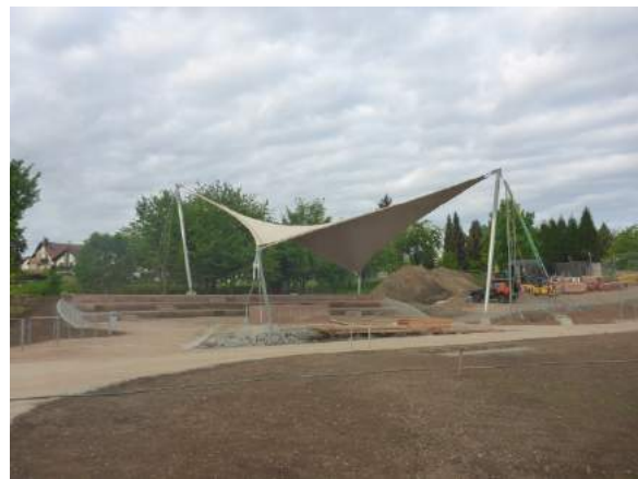
Sonnensegel: errichtet und abgespannt
