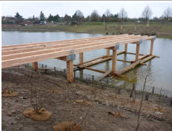
Einbau der tragenden Längsbalken
