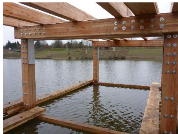
Einbau der tragenden Längsbalken
