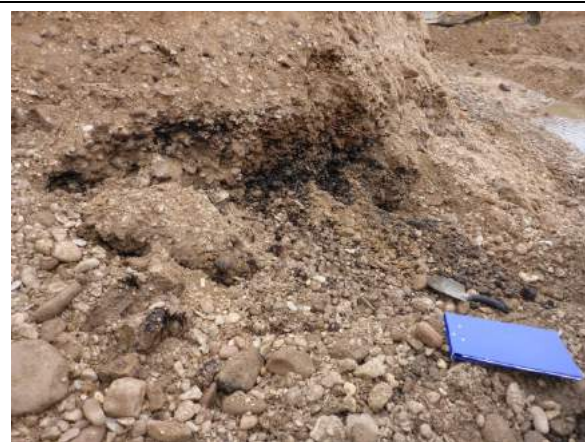
Erdarbeiten: Organische Einlagerungen im Kieskörper
