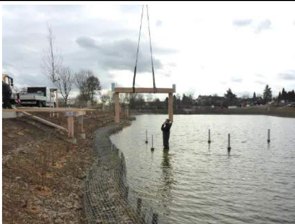
Einbau des Tragwerks (U-Ständer)
