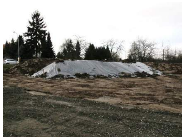
Oberbodenlagerung: Oberboden gelagert auf Halde für weitere Probenahme und Deklarationsanalytik durch den bodenkundlichen Fachgutachter, tagwasserdichte Abdeckung
