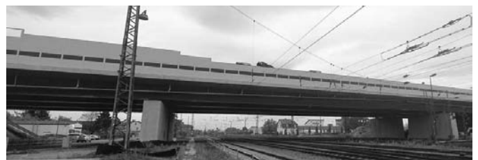
Bild 1: Einhub neue Stahlträger
