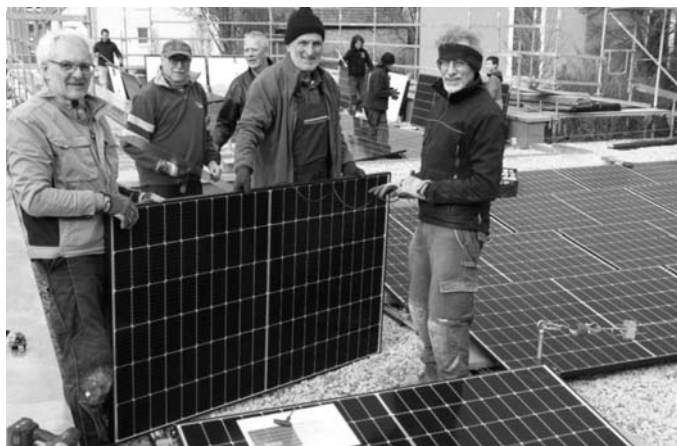
Die Ehrenamtlichen bei der Montage der PV-Anlage. Foto Kraus-Vierling RNZ
