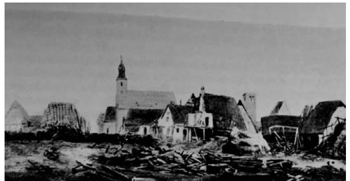
Eisgang 1784. Zerstörung großer Teile des Ortes. Auch das Schloss wurde beschädigt.
